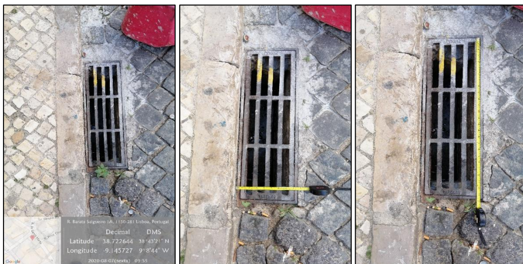
Figura 5.3 – Exemplo de levantamento dos dispositivos intercetores, bem como das variáveis necessárias para a determinação da sua eficiência
