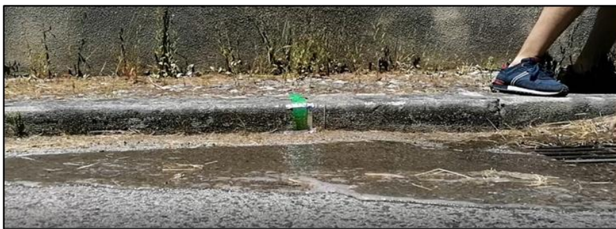
Figura 4.5 - Espriamento visível na campanha realizada a jusante do sumidouro 6 da zona de Civil
