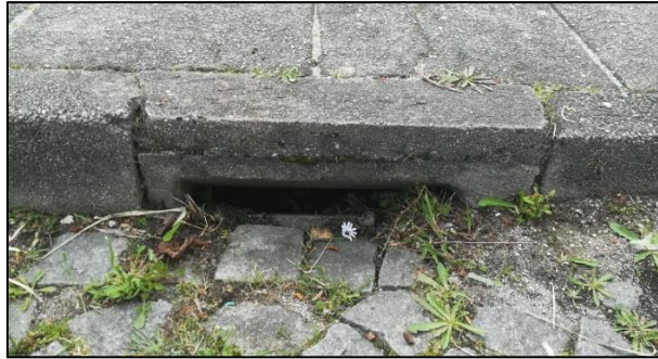
Figura 2.5 - Sarjeta sem depressão
