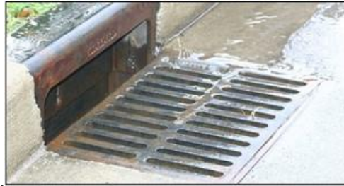
Figura 2.9 - Combinação de sumidouro e sarjeta (Fonte: (ADS 2020))
