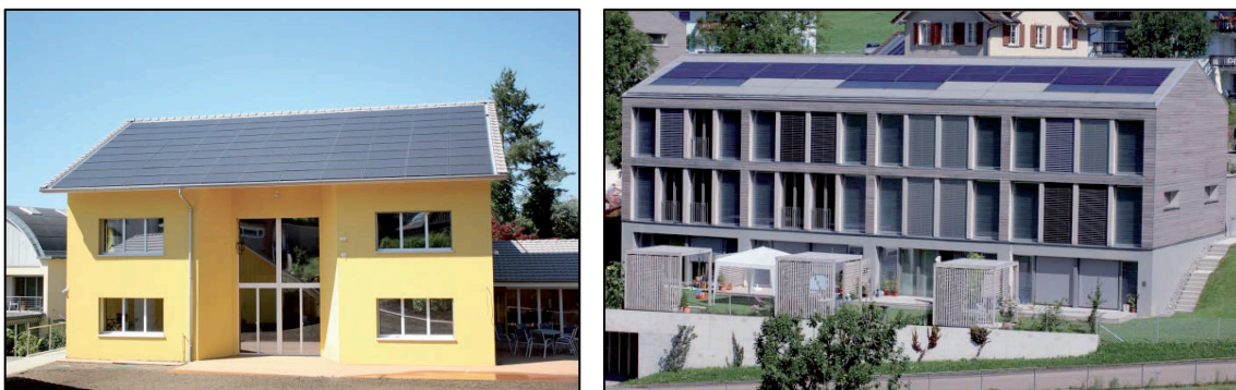
Figura 10: Coberturas construídas com módulos PV
