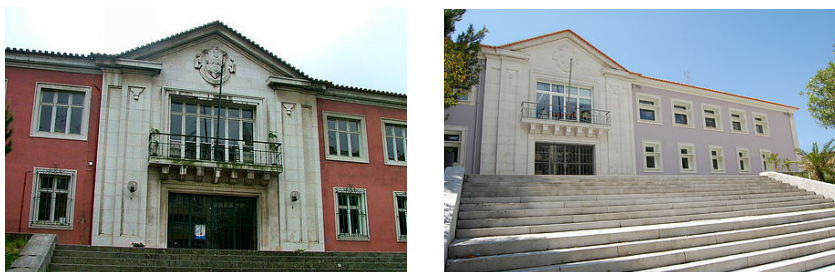
Figura 12: Escola básica e secundária Gil Vicente – antes e depois (exemplo do 2º período de construção) (Parque Escolar, 2019).
