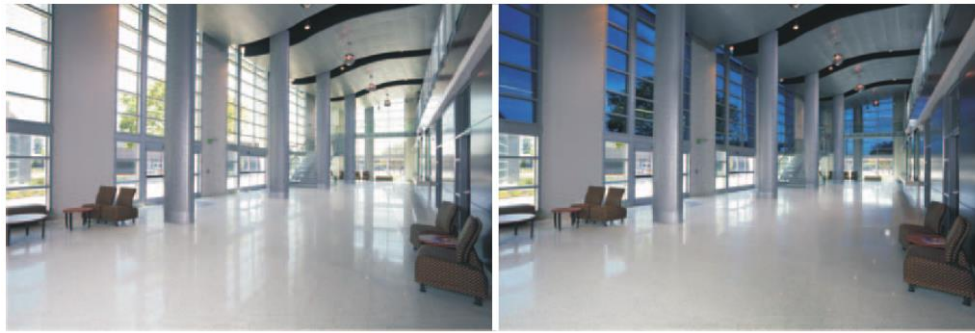
Figura 7- Janelas electrocrómicas at Chabot College, Califórnia
