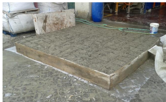
Figura 3.3 - Betão de origem após a betonagem
