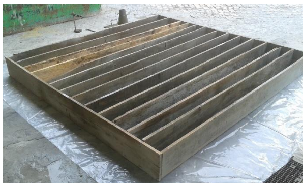
Figura 3.2 - Cofragem betão de origem
