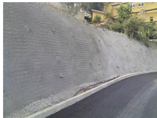
Figura 2.4 - Muro de contenção de terras em betão projetado, edifício Les Hautes de la Closerie, Nice, França (Peixoto, 2017)
