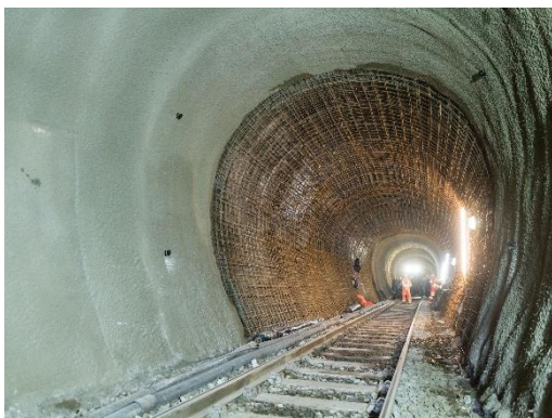
Figura 2.3 - Farnworth Tunnel revestido a betão projetado, Bolton, Reino Unido (Murphy, 2015)
