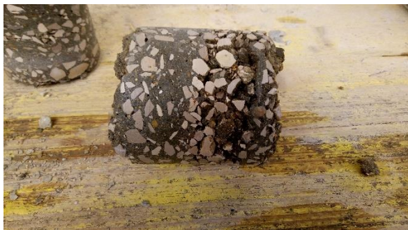
Figura 4.5 - Carote com material desagregado
