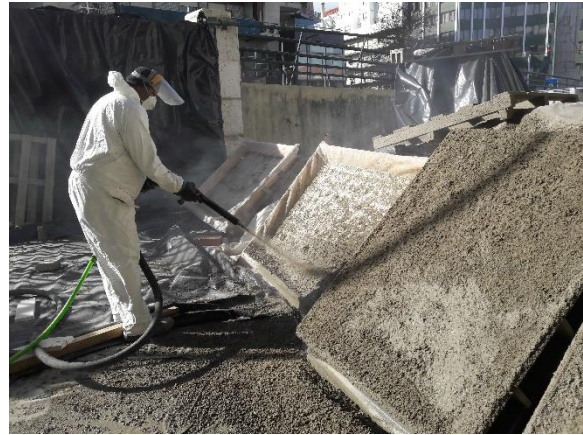
Figura 3.13 - Projeção por via seca
