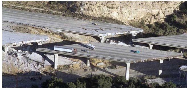
Figura 2.4. Rotura por queda de tabuleiro em Gavin Canyon (1994), [1]
