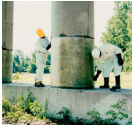
Figura 3.4. Pilar de uma ponte encamisado com mantas de CFRP, [3]
