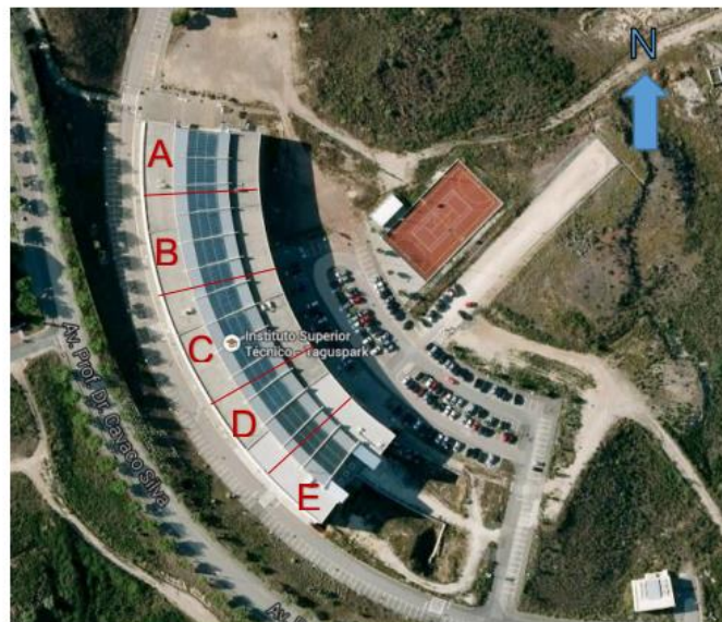
Figura 15- Edifício do IST-TagusPark e respetivos blocos. Retirado de Raposo (2015)
