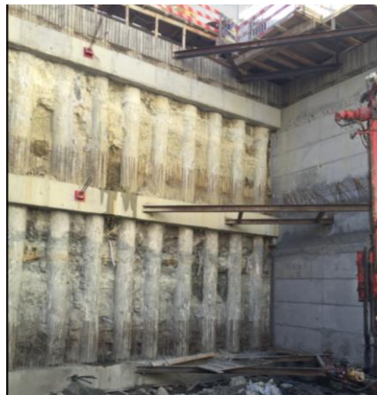
Figura 21: Escoramento metálico de canto [FPM41].
