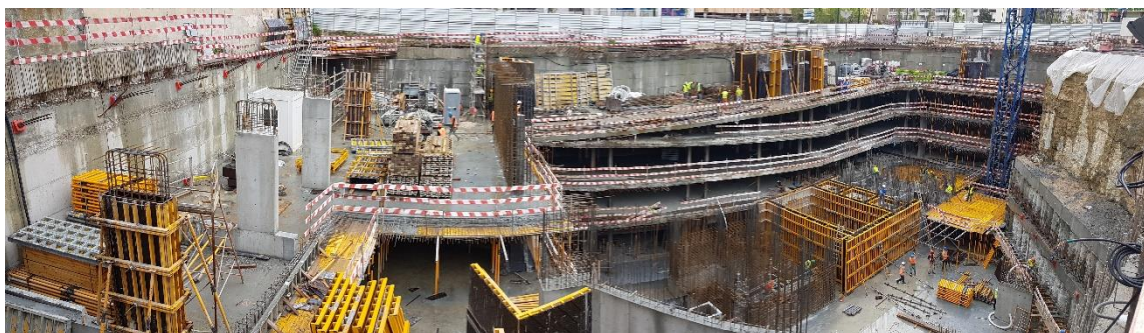
Figura 50: Lançada a laje do piso -4, visita 28/03/ 2017 [40].
