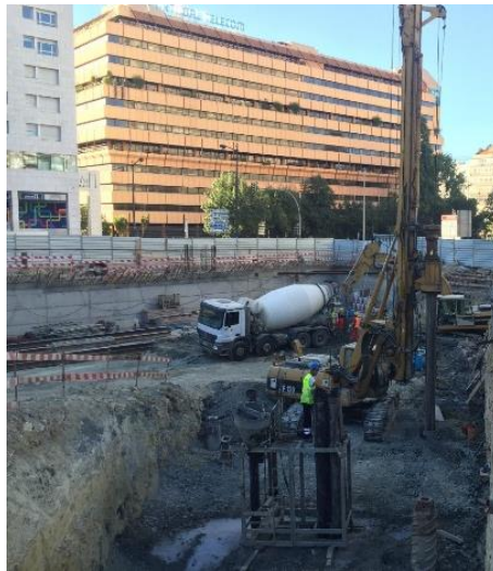
Figura 9: Trabalhos com o trado (FPM41).
