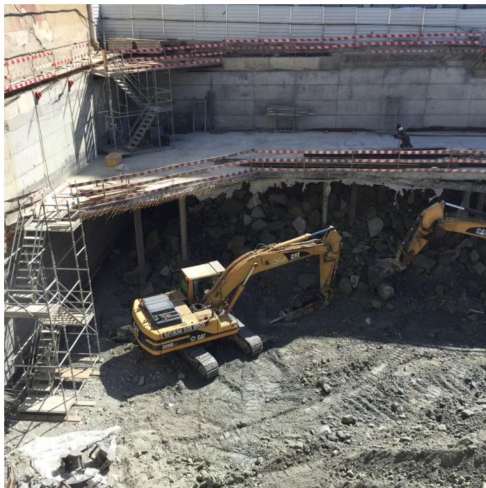
Figura 75: Escavação do nível -2, alçado AB.
