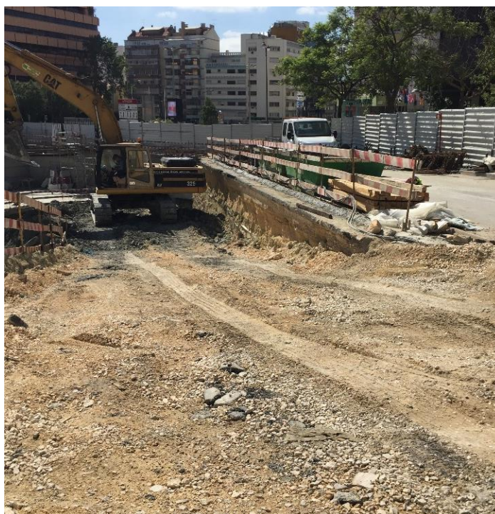
Figura 76: Escavação do núcleo do recinto de escavação.
