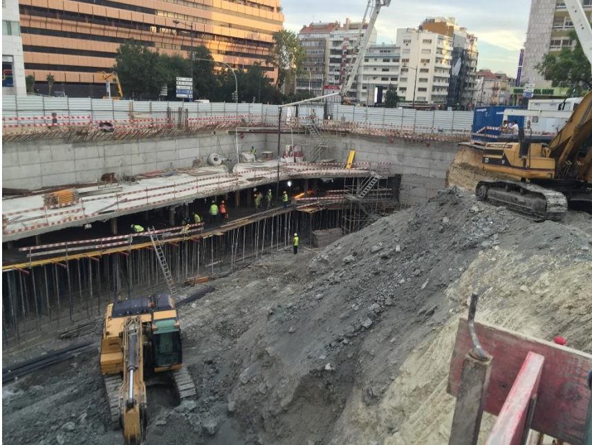
Figura 77: a Banda de laje betonada.
