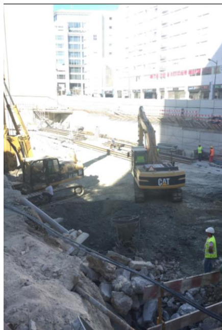
Figura 26: Interior do recinto de escavação na obra FPM41.
