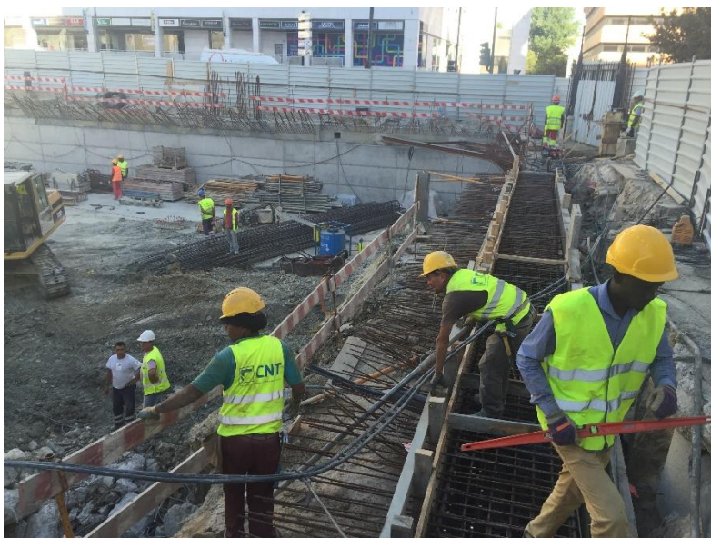
Figura 73: Trabalhos de Cofragem no Alçado BC.
