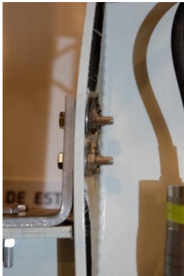
Figura 90 - Arrancamento das mantas e punçoamento do banzo da coluna num provete da série BC-8-F2-M.
