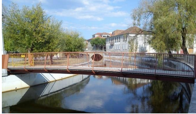
Figura 4 - Ponte pedonal em Viseu [15].
