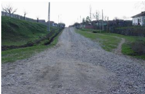
Figura 2.9: Estrada com desagregação. (MAI, 2005)
