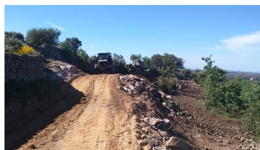
Figura 4.9: Construção da estrada.
