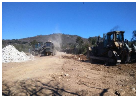
Figura 4.7: Trabalhos efetuados no terreno.
