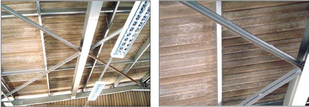
Figura 1.1: Exemplo de utilização de perfis de secção em “T” num sistema de contraventamento de uma cobertura.
