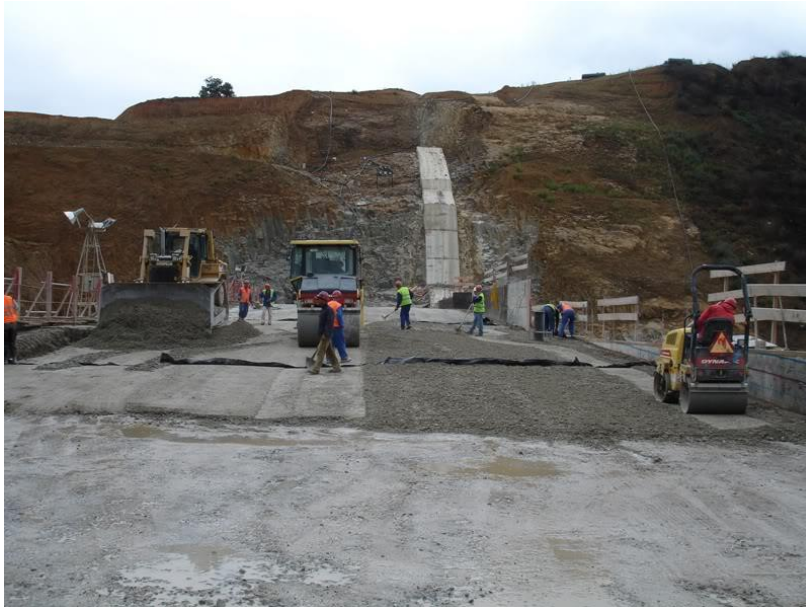
Figura 1 - Processo de compactação de uma camada de BCC [16]
