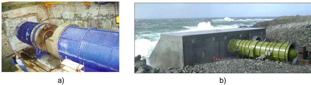
Figura 2.8 – a) Grupo turbina-gerador da Central da Ilha do Pico [17]; b) – Central LIMPET instalada na ilha de Islay, Escócia [3]
