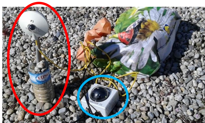
Figura 4.12 - Sensores utilizados na cobertura (a vermelho o piranómetro vertical da Kipp&Zonen CMP6 e a azul o piranómetro horizontal BF5).
