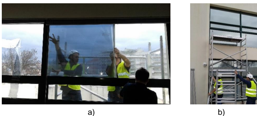
Figura 4.5 - Remoção (a) e aplicação pelo exterior (b) das películas.
