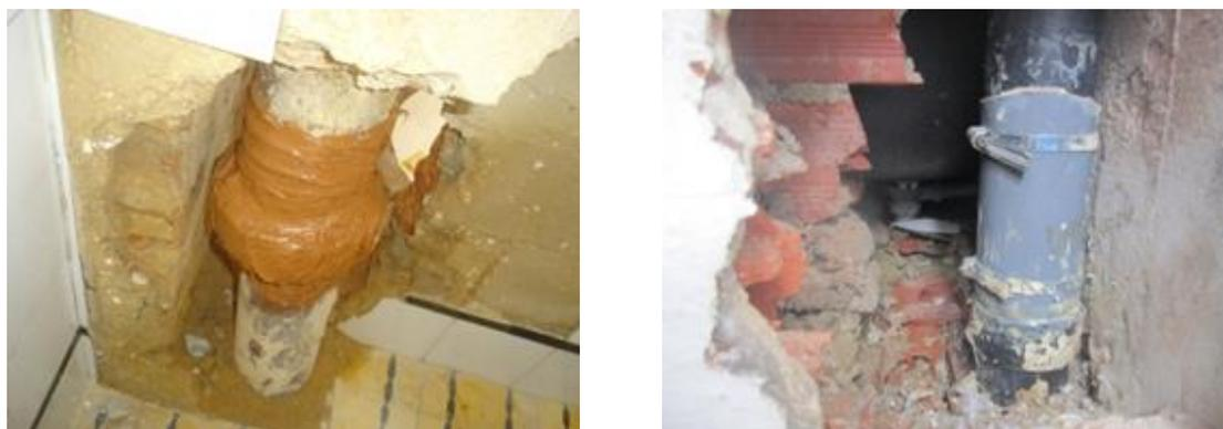
Figura 3.30 – Solução de reparação em tubos de queda da rede de drenagem de águas residuais
