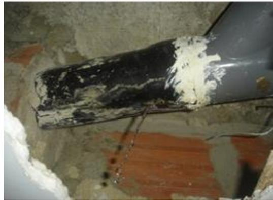
Figura 3.21 – Roturas em ramais de descarga
