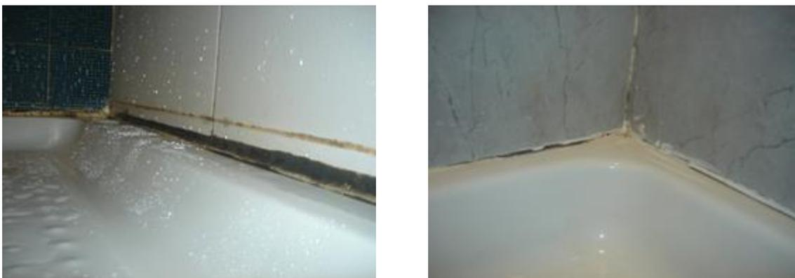
Figura 2.10 – Deficiências de isolamento do vedante nas juntas entre a base de duche e os azulejos
