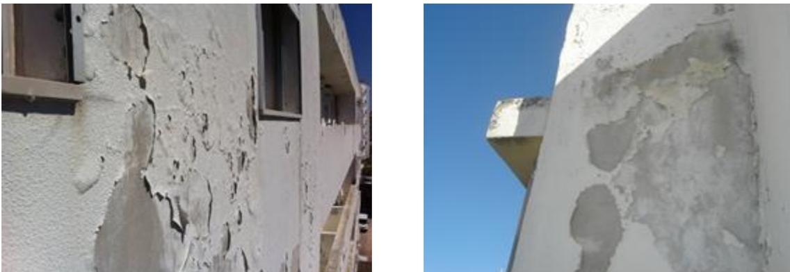
Figura 2.3 – Destacamento do revestimento em pintura de paredes exteriores
