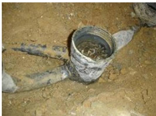
Figura 3.24 – Roturas em acessórios da rede de águas residuais
