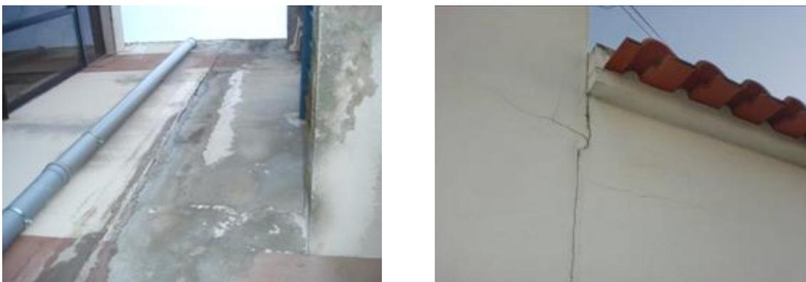
Figura 2.4 – Degradação e fissuração de juntas de dilatação em edifícios
