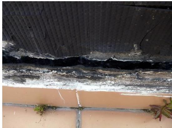
Figura 2.7 – Descolamento dos remates em platibandas
