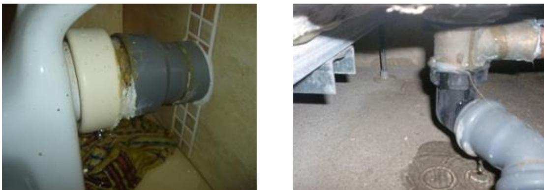
Figura 3.29 – Deficiências de estanquidade devido a desgaste das juntas de ligação das tubagens
