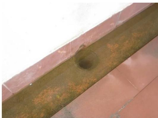
Figura 3.25 – Entupimentos de caleiras do sistema de drenagem de águas pluviais de coberturas
