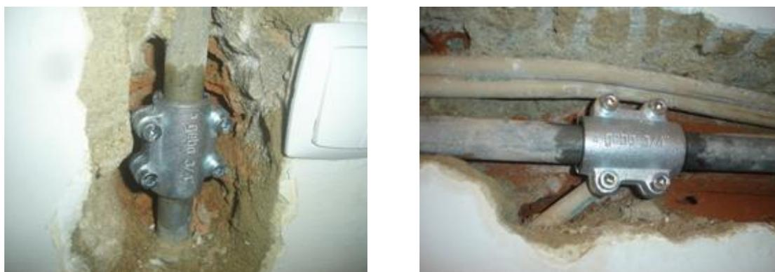
Figura 3.31 – Reparação com recurso a braçadeira de tubagens em aço galvanizado
