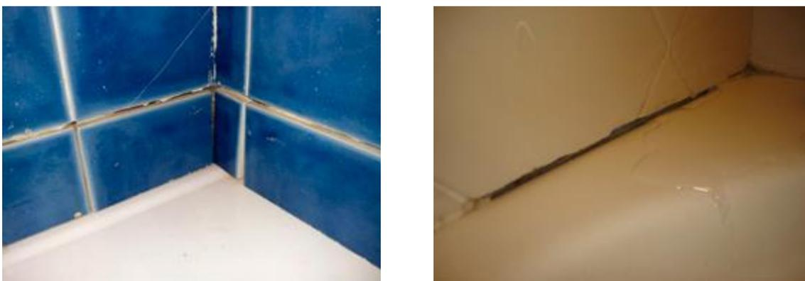
Figura 2.9 – Degradação da massa de enchimento das juntas de azulejos de instalações sanitárias
