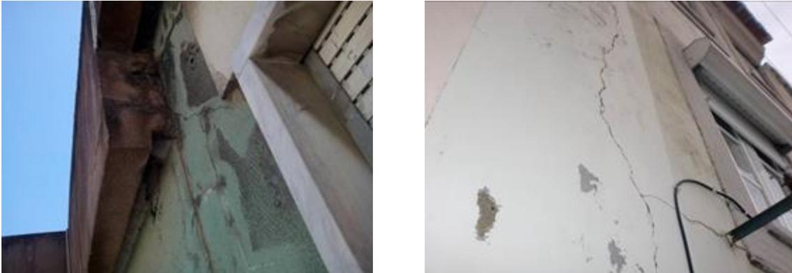
Figura 2.2 – Fissuração existente em paredes exteriores
