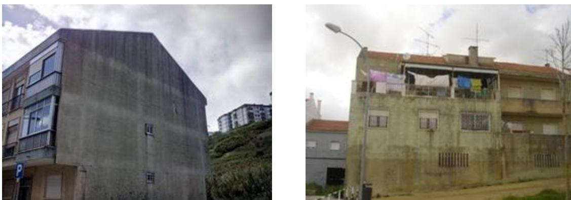
Figura 2.1 - Influência da orientação das fachadas na degradação de edifícios
