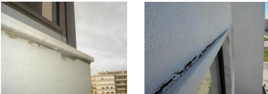
Figura 2.5 – Desgaste e desprendimento do material de vedação do peitoril e moldura da janela
