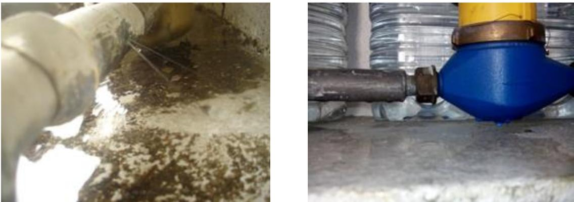
Figura 3.8 – Rotura em tubagem de chumbo
