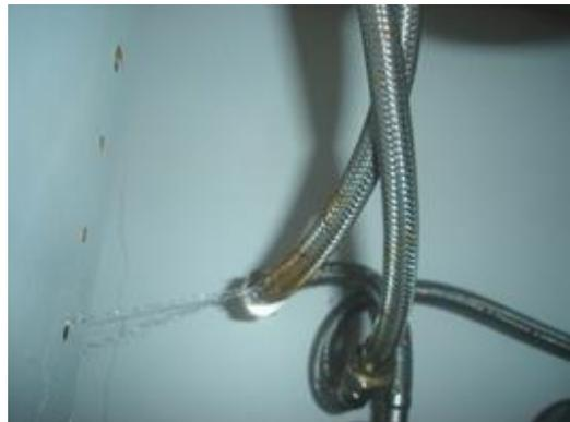
Figura 3.19 – Roturas em acessórios da rede de distribuição
