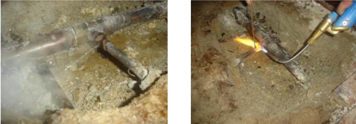
Figura 3.7 – Rotura em tubagem de cobre
