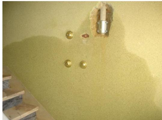
Figura 3.16 – Roturas em colunas de distribuição
