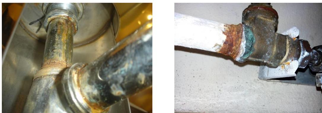
Figura 3.28 – Identificação de acessórios com corrosão em ação de manutenção preventiva condicionada
