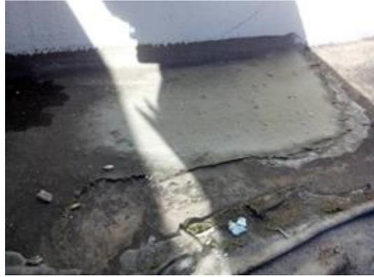
Figura 2.6 – Fissuração e arrancamento de revestimentos da cobertura em terraço
