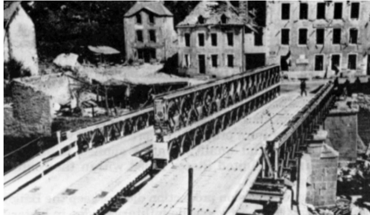
Figura 19 : Ponte Bailey com tráfego de dois sentidos (retirado de (ThinkDefence, 2012))
