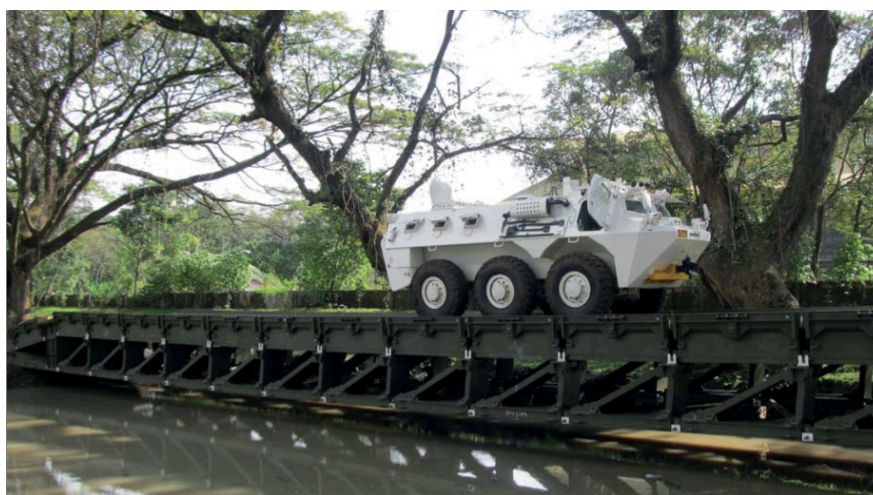
Figura 6 : Ponte MGB de configuração de dois níveis (retirado de (WFEL, 2018))
