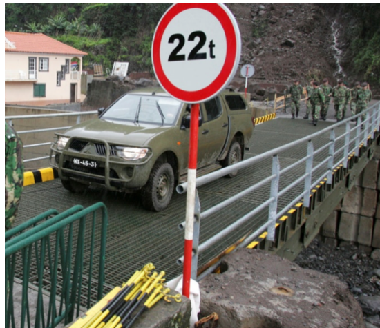
Figura 1 : Ponte montada na Madeira depois das cheias de 2010 (adaptado de (RTP, 2010))
