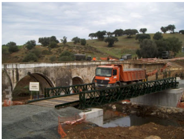
Figura 21 : Ponte Bailey em Ferreira do Alentejo (retirado de (JJ, 2010))
