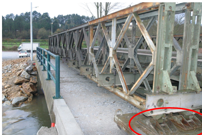
Figura 18 : Ponte Bailey com apoios de configuração dupla (adaptado de (Companhia de Pontes, 2015))
