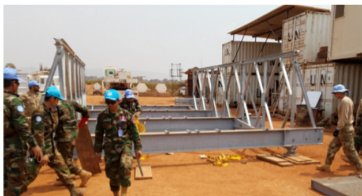
Figura 29 : Ponte Acrow montada na RCA no âmbito da MINUSCA (retirado de (Acrow Bridge, 2018))
