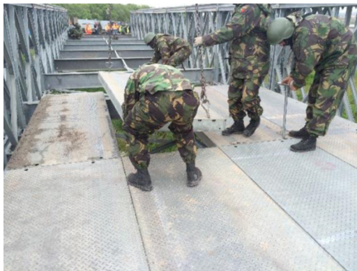
Figura 26 : Montagem da ponte Compact 200 em Figueira da Foz (retirado de (Fardilha, 2016))
