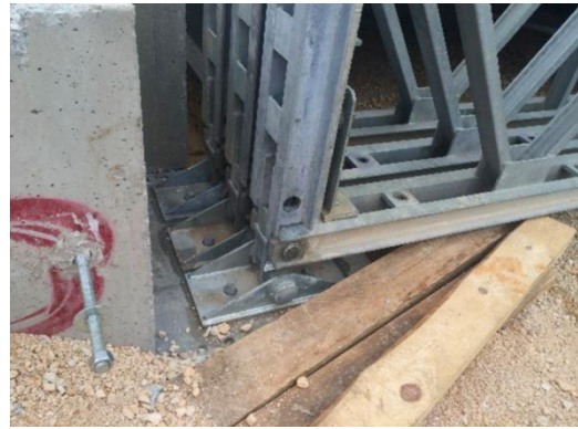
Figura 27 : Configuração tripla do encontro feito na ponte Compact 200 na Figueira da Foz (retirado de (Fardilha, 2016))
