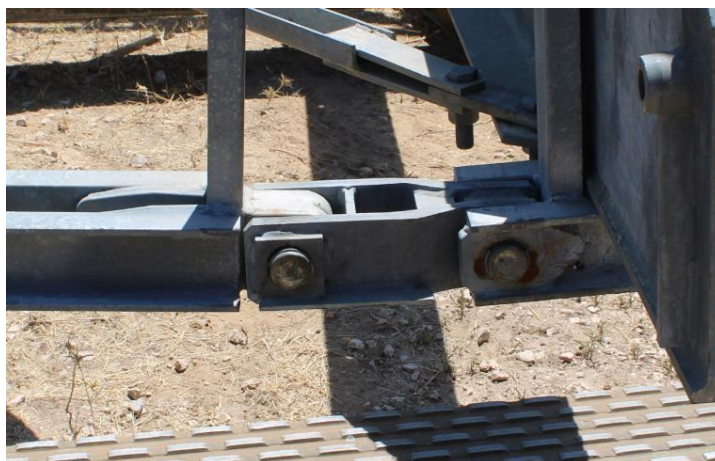
Figura 58 - Ligação de lançamento utilizada, fotografia tirada em Tancos dia 10/07/2020
