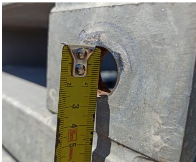
Figura 52 - Diâmetro da ligação em estudo. Adaptado de Companhia de Pontes (2020)
