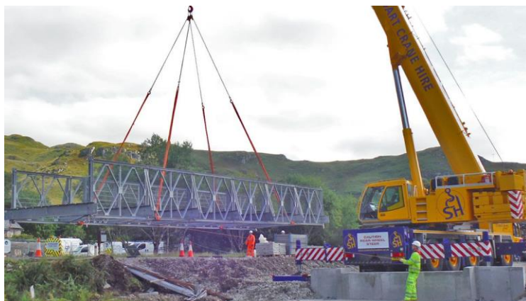
Figura 15 - Montagem através de uma grua na Escócia. Adaptado de Mabey Bridge (2020)
