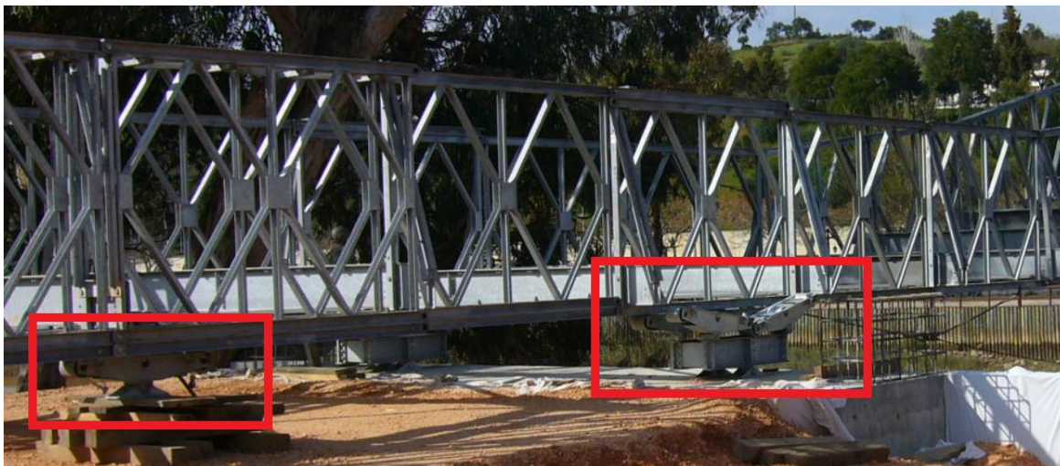
Figura 17 - Da esquerda para a direita, roletes de construção e roletes de lançamento.
