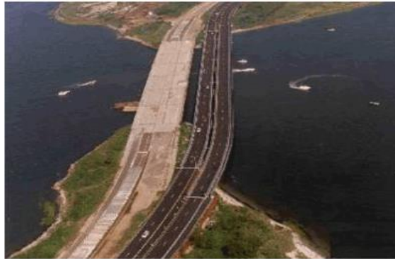
Figura 11 - Ponte Acrow usada para substituir ponte a ser intervencionada em New York. Adaptado de Federal Highway Administration (2017)
