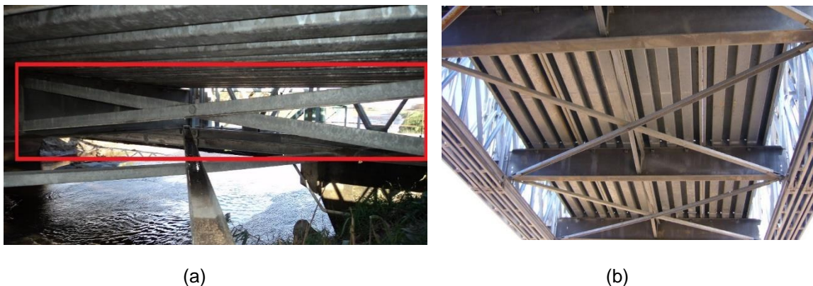
Figura 36 - a) Esticadores Verticais; b) Esticadores horizontais e verticais.
