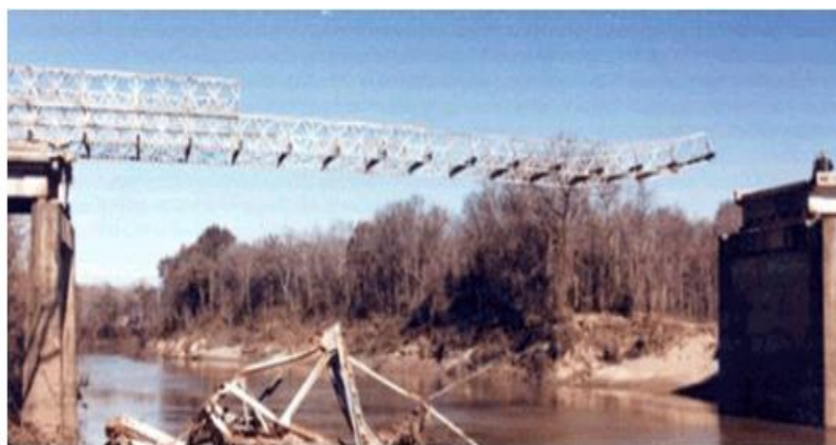
Figura 6 - Lançamento da ponte Bailey. Adaptado de Federal Highway Administration (2017)
