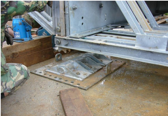
Figura 21 - À esquerda apoio de extremidade e à direita apoio de continuidade (móvel). Adaptado de Companhia de Pontes e Mabey Bridge (2014)
