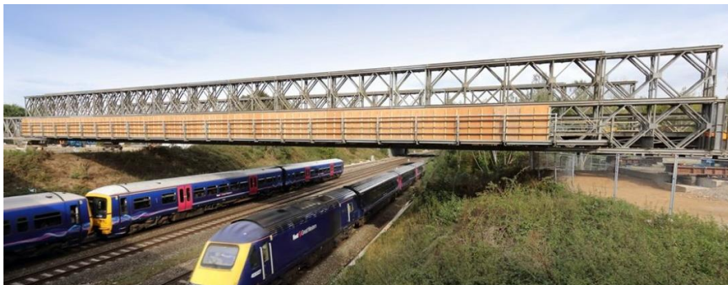
Figura 48 - Utilização de painéis sobrepostos no Reino Unido. Adaptado de Mabey Bridge 2020
