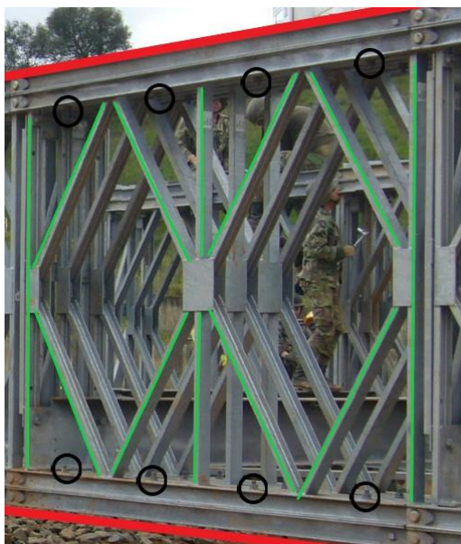
Figura 56 - Reforços/alterações representadas num painel-tipo
