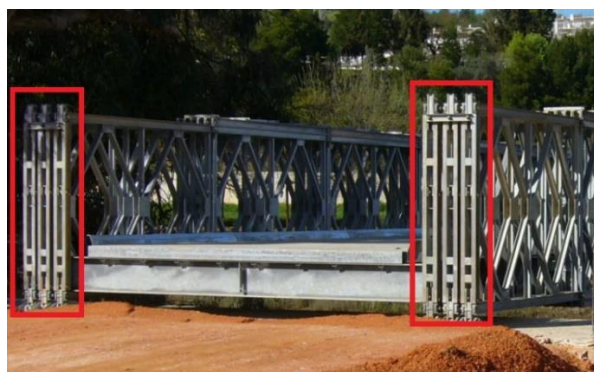
Figura 33 - Postes na configuração TSHR3H. Adaptado de Companhia de Pontes (2011)
