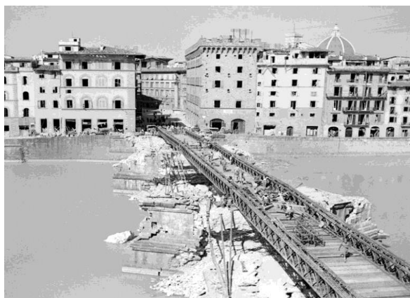
Figura 4 - Ponte Bailey a substituir ponte destruída em Florença. Adaptado de ThinkDefence (2012)
