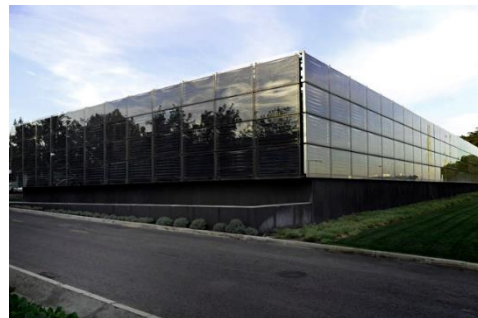
Figura 2.2 - Centro de Controlo Operacional da Brisa (Guias de Arquitetura, S.D)
