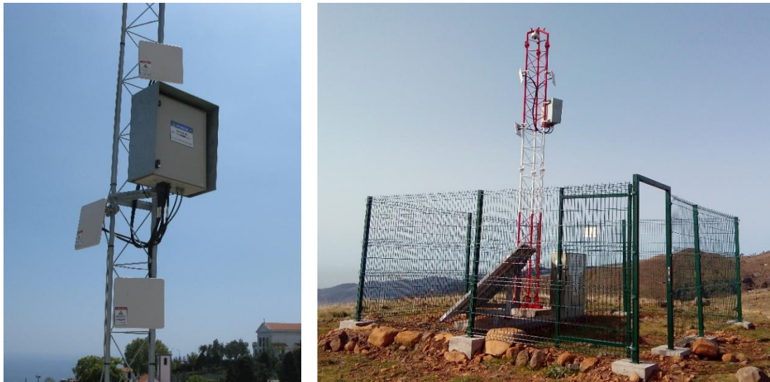
Figura 4.5 – Estação GW0 e GW3 da rede de monitorização de ribeiras, respetivamente.
