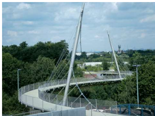
Figura 2 - Ponte pedonal de Gahlensche Straße (retirado de Idelberger 2011).
