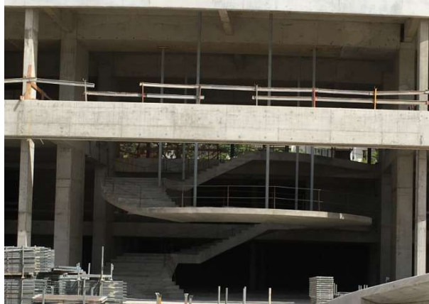
Figura 3 - Hall de entrada do hotel Savoy Palace na Madeira (JSJ).
