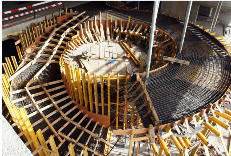
ANEXO 13 - Posicionamento das armaduras e dos tirantes (foto de Rui Marote).
