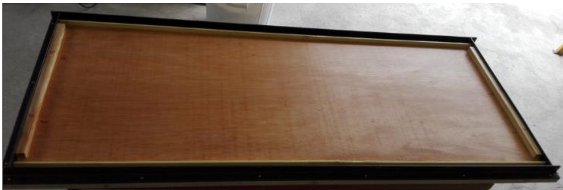
Figura 4.6 – Cofragem em madeira
