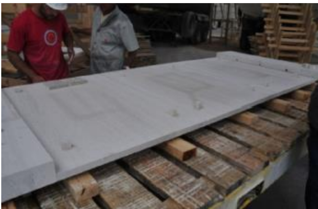
Figura 2.3 – Montagem dos componentes do painel (em pedra)
