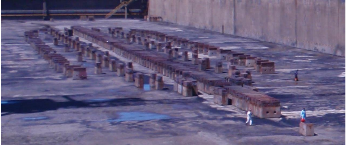
Figura 11. Exemplo da colocação dos picadeiros na doca 21.
