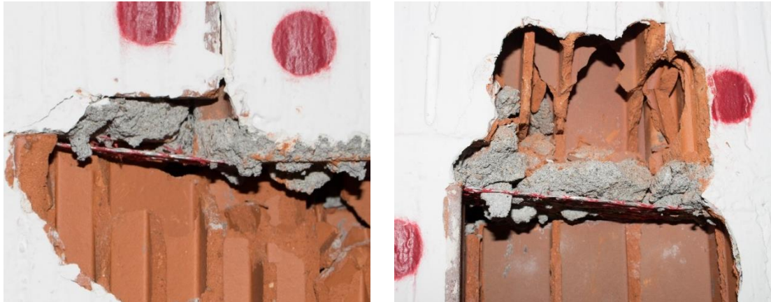
Figura 4.23 - Armadura de junta "Murfor Compact I" tracionada no final do ensaio.
