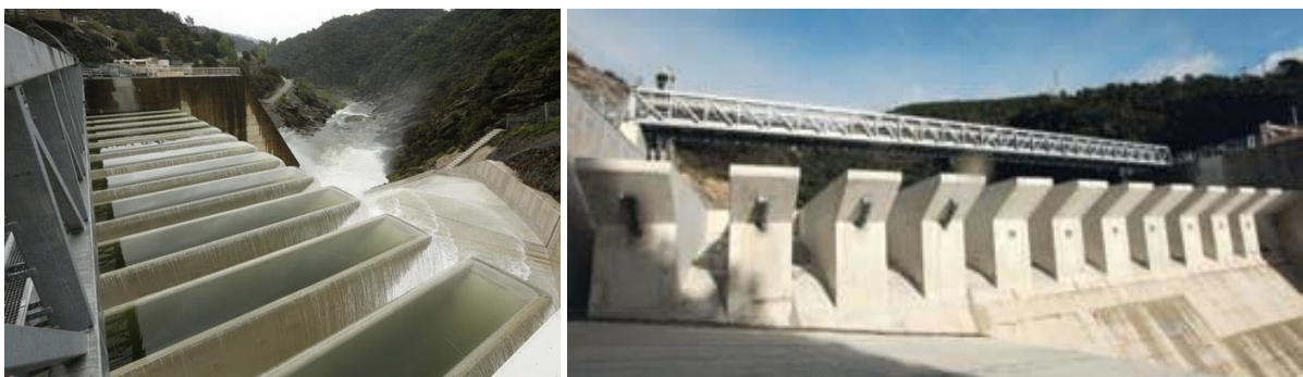
Figura 2.2 – Barragem de Malarce, em França (retirado a 2 de dezembro de 2017, de http://www.climatesolutionsplatform.org/solution/piano-keys-to-handle-exceptional-floods/ ).
