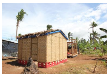
Figura 3.2 – Paredes de folha de bambu trançado. Adaptado de Shigeru Ban Architects (2014)
