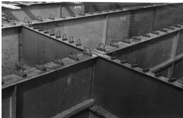
FIGURA 2.1 - VIGAS MISTAS COM CONECTORES EM VARÃO SOLDADOS PARA A PONTE HERDECKE SOBRE O RIO RUHR (1951) - RETIRADO DE (PELKE & KURRER, 2015)
