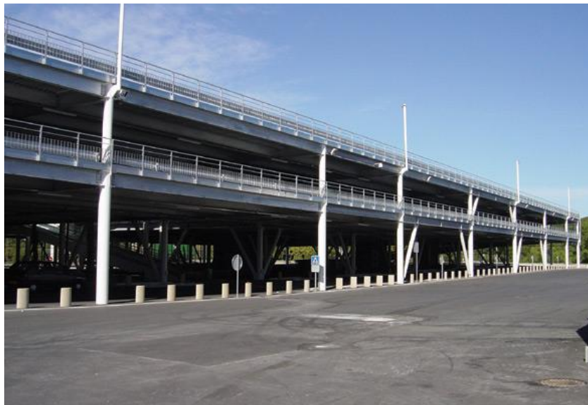
FIGURA 2.5 - VISTA EXTERIOR DO PARQUE DE ESTACIONAMENTO – RETIRADO DE (ARCELORMITTAL, 2004)
