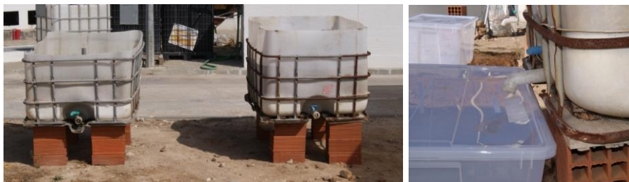
Figura 12 - Montagem dos leitos de secagem da instalação piloto e pormenor da torneira e recipiente de recolha e armazenamento da água drenada
