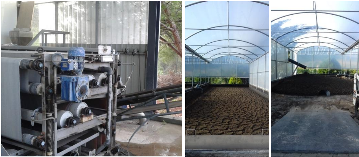
a) b) c) Figura II 1 - Processos integrantes da linha de desidratção de lamas da ETAR da Póvoa da Galega: a) filtros banda, b) leito de secagem, c) leito de armazenamento
