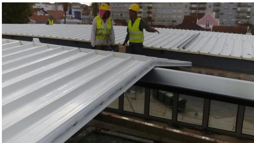
Figura 10- Substituição da Cobertura
