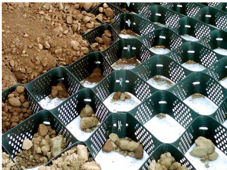
Figura 2.13: Geocélula (Geosystems, s.d.).
