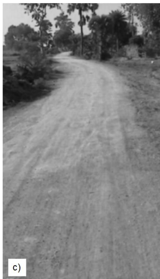
Figura 2.9: Condições da estrada: a) Inicialmente, sem reforço; b) Decorridos 18 meses da aplicação do geotêxtil de reforço; e c) Decorridos 12 meses sem a aplicação de geotêxtil. (Adaptado de Basu et al, 2009)
