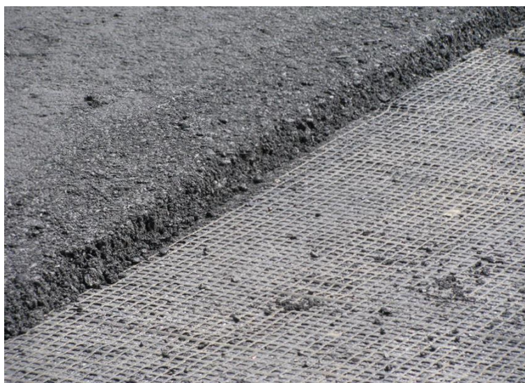
Figura 2.11: Geogrelha de fibra de carbono pré-betuminada. (S&P, s.d.)
