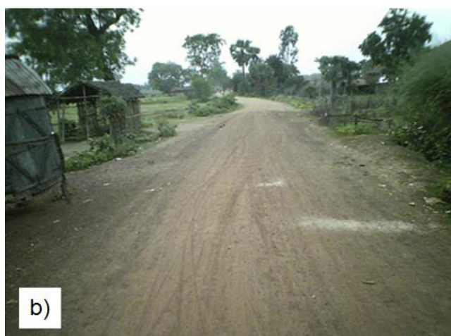
Figura 2.9: Condições da estrada: a) Inicialmente, sem reforço; b) Decorridos 18 meses da aplicação do geotêxtil de reforço; e c) Decorridos 12 meses sem a aplicação de geotêxtil. (Adaptado de Basu et al, 2009)
