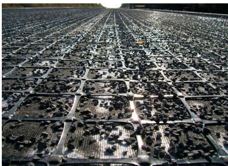
Figura 2.10: Geogrelha de polipropileno. (TENSAR, s.d.)
