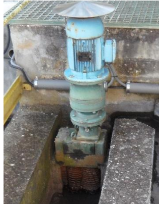
Figura 11 – Triturador, ETAR do hospital Dr. José Maria Antunes Júnior em Torres Vedras.
