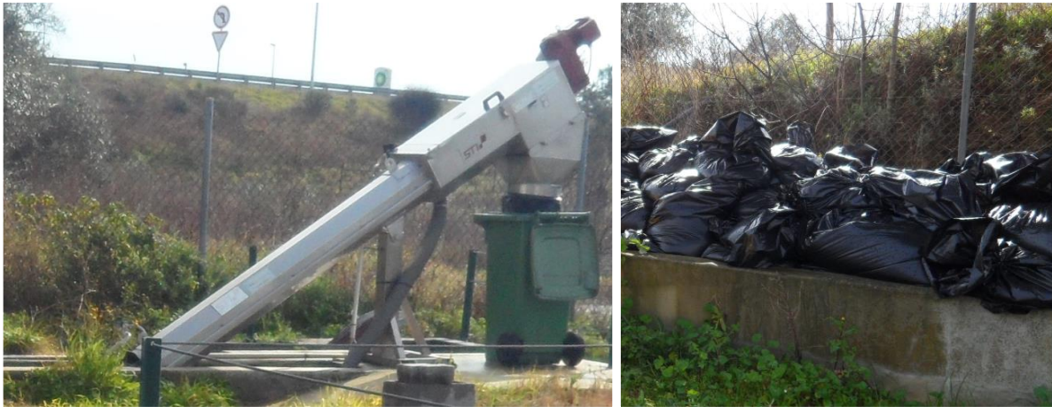
Figura 36 – Recolha de gradados da ETAR da Área de Serviço da BP de Santarém. À esquerda tamisador com deposição de gradados num contentor, e à direita deposição dos sacos retirados do contentor até recolha para destino final apropriado.
