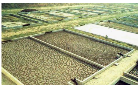
Figura 27 – Leitos de secagem (Matos, 2013)
