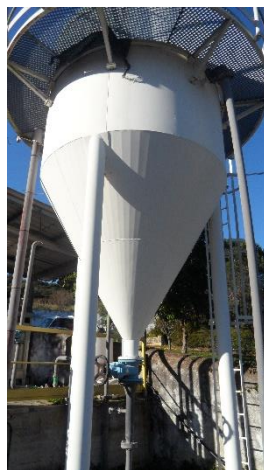
Figura 26 – Espessador gravítico de lamas, ETAR do hospital Dr. José Maria Antunes Júnior em Torres Vedras.
