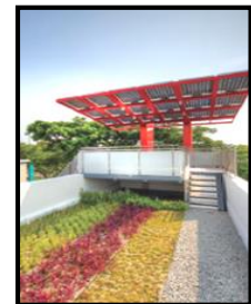
Figura 32 – Telhado verde do ZEB. Fonte: Autora, Julho 2015
