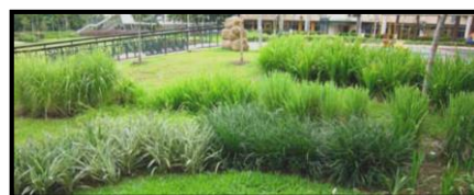
Figura 21 – Valas de bioretenção do parque Firefly Park. Fonte: Autora, Julho
