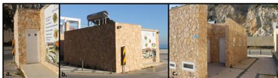
Figura 60 – Casas de banho (a.), duches e lava pés(c.) disponíveis na praia da Figueirinha. Painel solar instalado no telhado aproveitamento para os equipamentos e iluminação pública (c.). Fonte: Autora, Julho 2015.
