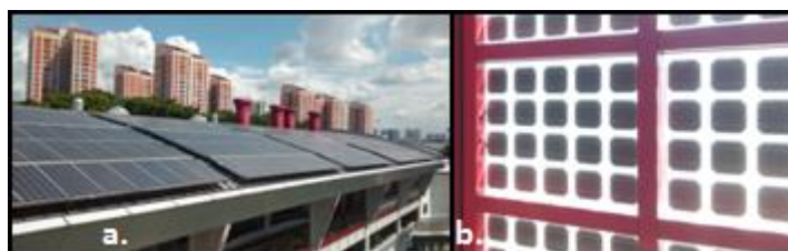
Figura 39 – Painéis solares ao longo do telhado (a.) e colocados nas fachadas de vidro dos corredores e escadas interiores (b.). Fonte: Autora, Junho 2015.
