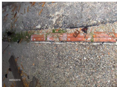
Figura 8 - Zona de demolição da platibanda do edifício inicial.
