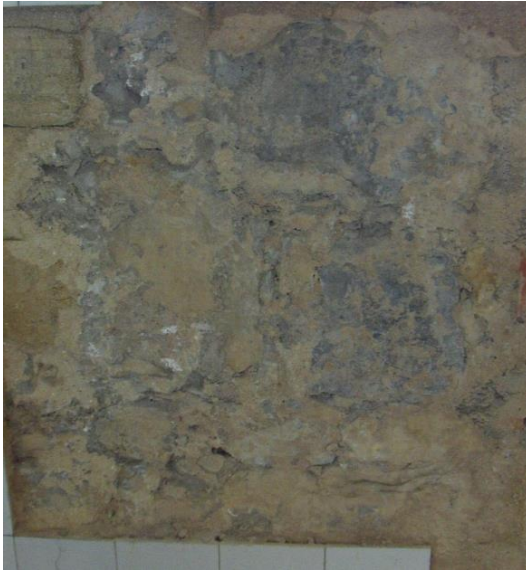
Figura 32 - Parede de alvenaria de pedra em estudo.
