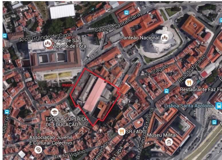
Figura 5 - Imagem aérea da localização e enquadramento geral do PM050/Lisboa
