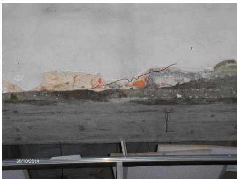
Figura 7 - Zona de ligação entre o novo e o existente.
