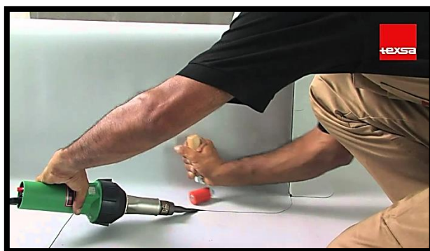
Figura 22 - Termossoldadura a ar quente da membrana sintética de PVC (TEXSA, 2015)
